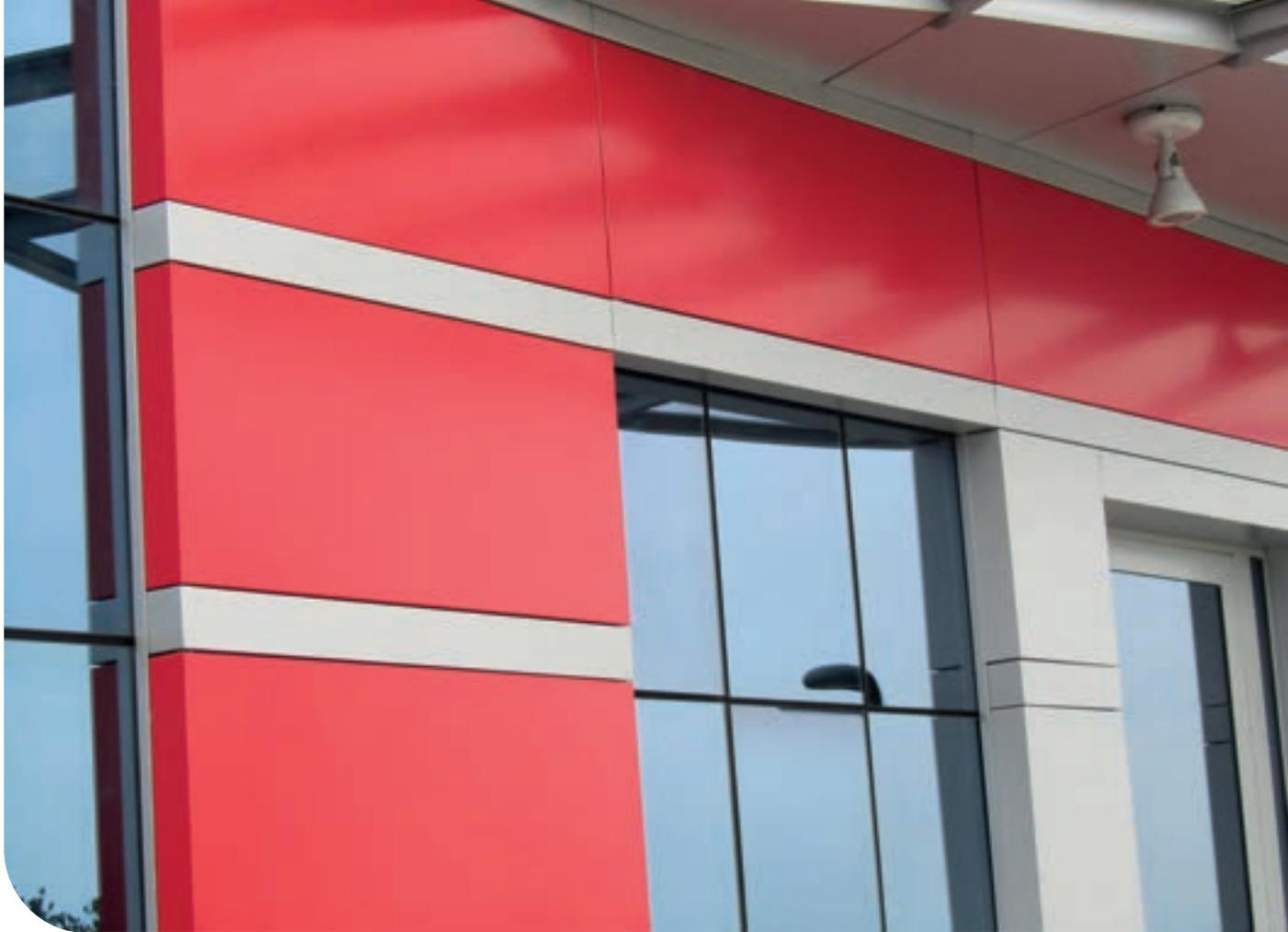
L'alluminio composito, noto anche come alluminio composito rivestito (ACM), è un materiale da costruzione leggero e resistente. È composto da due sottili fogli di alluminio che sono termo-legati a un nucleo di materiale non metallico, come polietilene o poliuretano. Questo materiale è ampiamente utilizzato nell'industria dell'edilizia per rivestimenti esterni, pannelli pubblicitari e insegne, grazie alla sua resistenza, leggerezza e capacità di essere modellato in varie forme.
